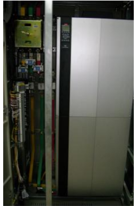
FC302P250变频器在洛阳多晶硅生产车间
